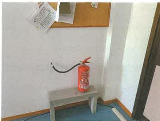
Figura 2. Estintore presente non correttamente installato a muro
