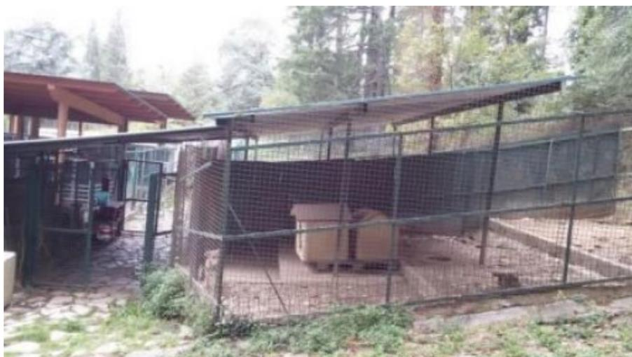
Un'ulteriore tettoia sorge in prossimità di quella precedente descritta. Questa è realizzata completamente in metallo sia per le strutture portanti (travi e pilastri) che per la copertura (in pannelli metallici).
