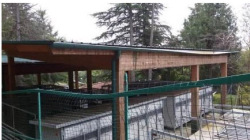
Adiacente all'edificio precedentemente descritto si trova una tettoia realizzata con travi e travicelli in legno, avente forma rettangolare e copertura a due falde distinte. La tettoia, sorretta da dodici pilastri lignei, è dotata di copertura con lamiera grecata metallica ed ospita le cuccie dei cani riparando gli stessi dagli agenti atmosferici.
